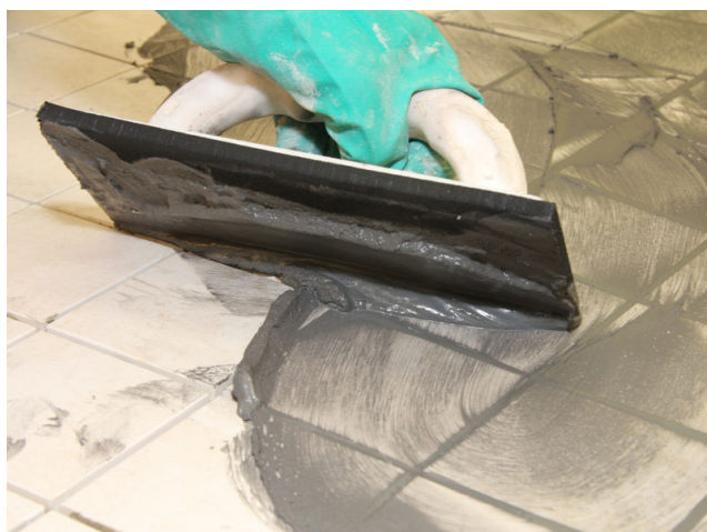
Einfugen von Sopro DF 10 in Feinsteinzeugfliesen.
