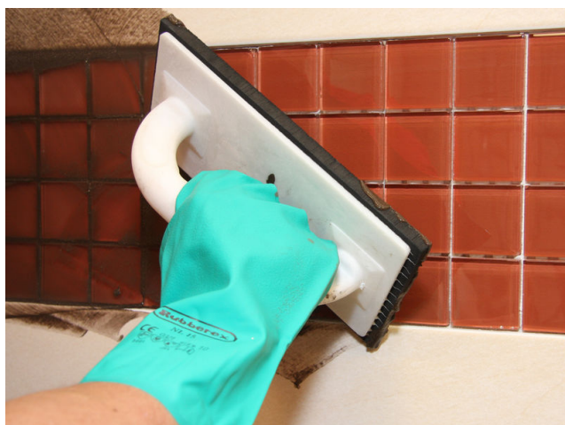
Einfugen von Sopro DF 10 in Glasmosaik.
