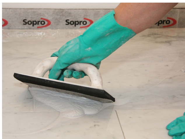
Einfugen von Sopro DF 10 in verarbeitungsempfindlichen Naturstein.
