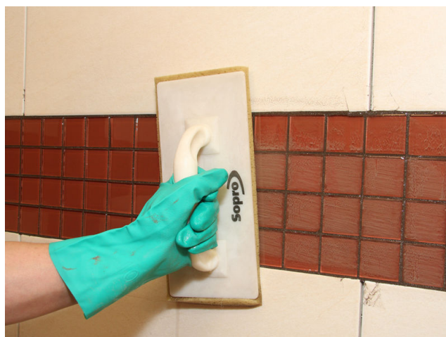
Abwaschen des Glasmosaiks nach ausreichender Standzeit des Fugenmörtels.
