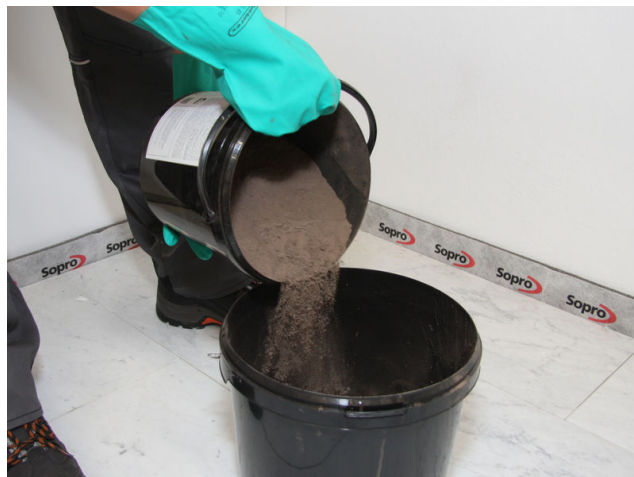
Sopro DF 10 zudosieren und maschinell anrühren.
